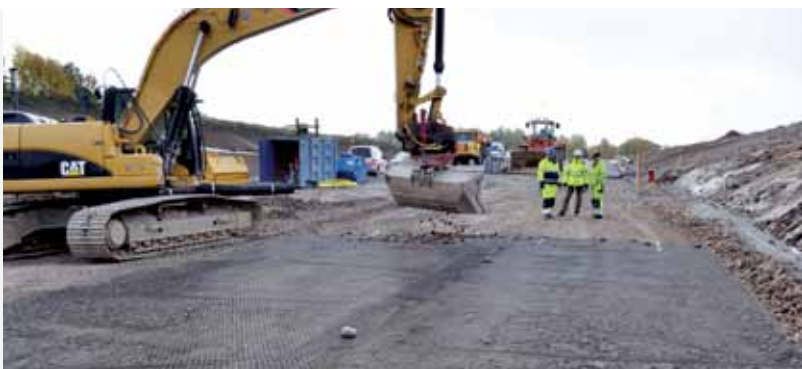
Förstärkning av överbyggnad, Ringvägen Linköping
