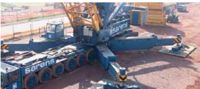
Mycket tung kran på en arbetsplattform som är stabiliserad med Tensar geonät
