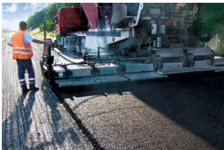
Vägbeläggningen läggs direkt på Tensar AR-GN.
