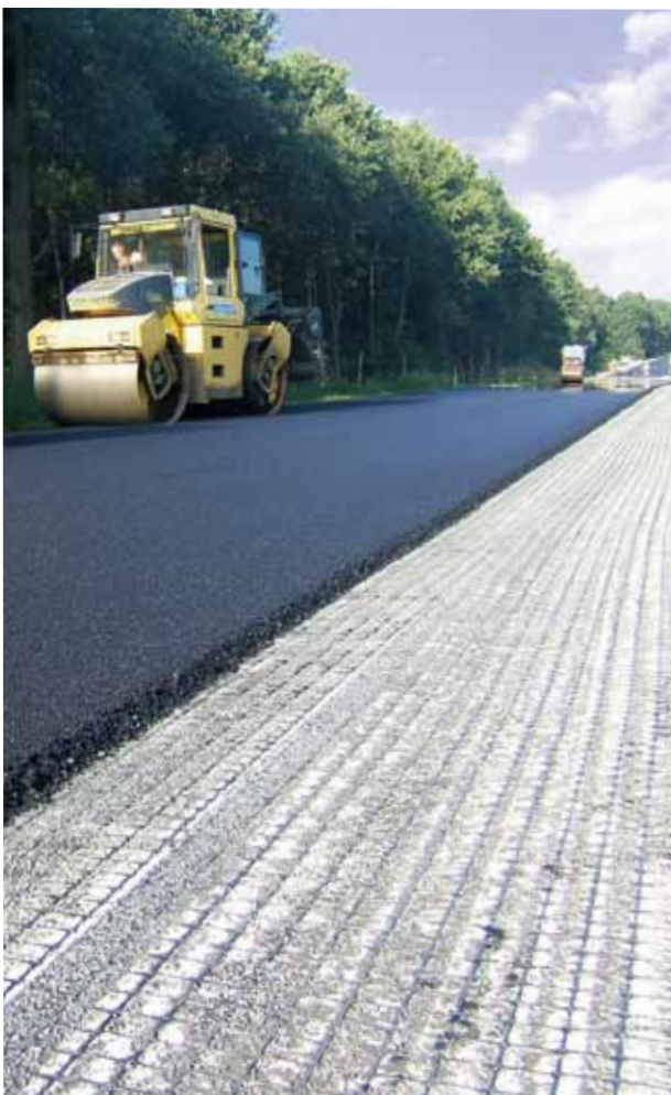
Tensar AR-GN fäster bra på den underliggande ytan så att vägbeläggningen kan läggas ut direkt på nätet.
