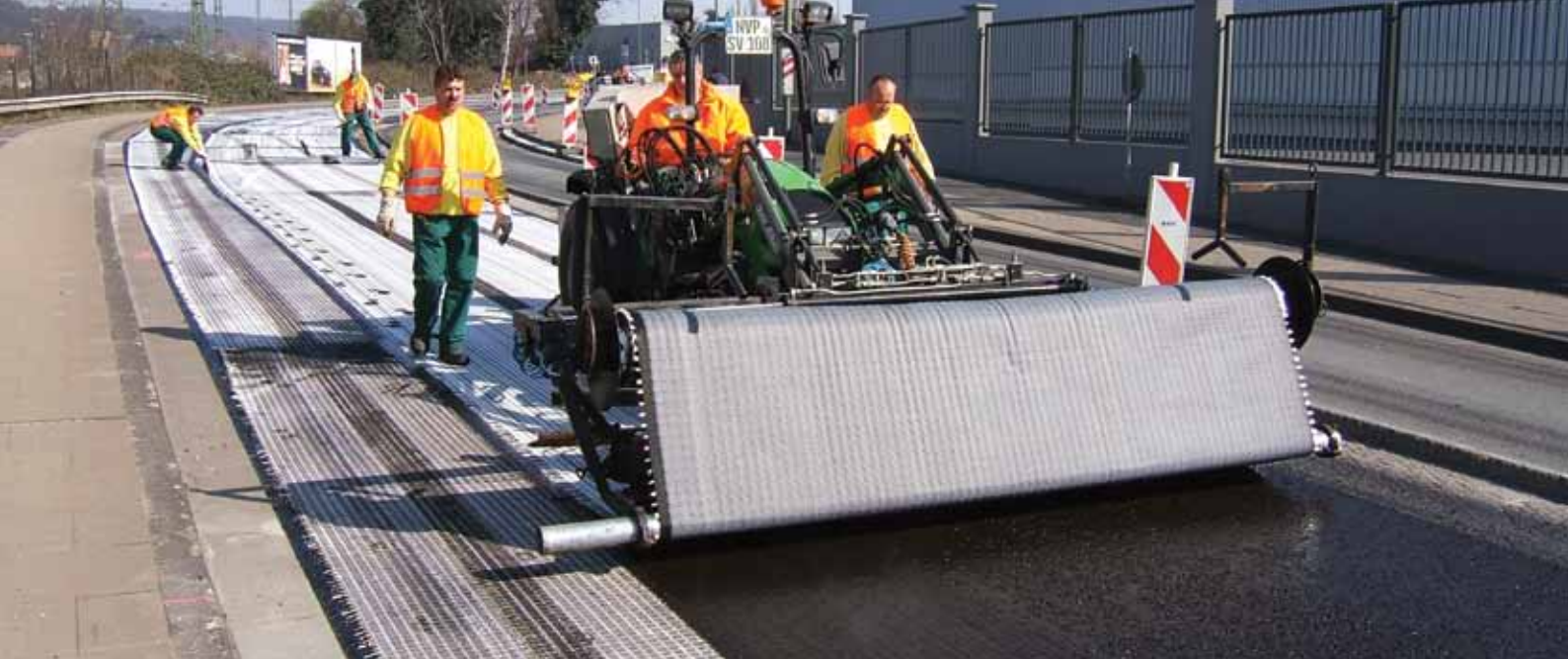
Det går snabbt och effektivt att installera Tensar Glasstex mekaniskt – ett erfaret team kan installera upp till 12 000 kvadratmeter per dag och per maskin.
