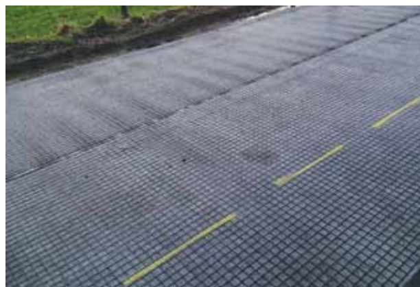
Tensar AR-GN kan motverka utmattningssprickor och minska sprickor som beror på långvariga differentialrörelser i undergrunden.
