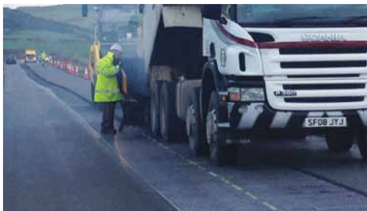
Tensar AR-GN kan motverka utmattningssprickor och minska sprickor som beror på långvariga differentialrörelser i undergrunden.
