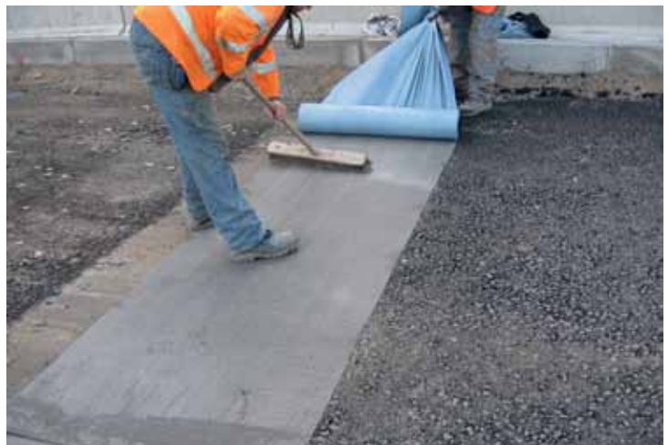
GlasstexPatch 880 kan appliceras direkt på de flesta felfria underlag med hjälp av den klisterskiktet.
